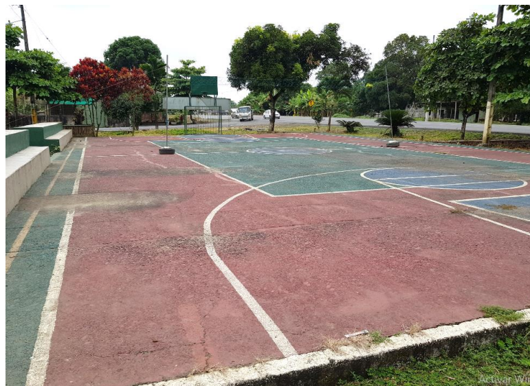
Ilustración 92-Cancha del recinto Faita Fuente: Equipo Consultor – 2020
