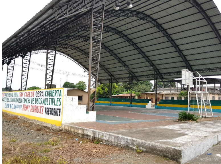
Ilustración 87-Cancha de uso múltiple, cabecera parroquial Fuente: Equipo Consultor - 2020
