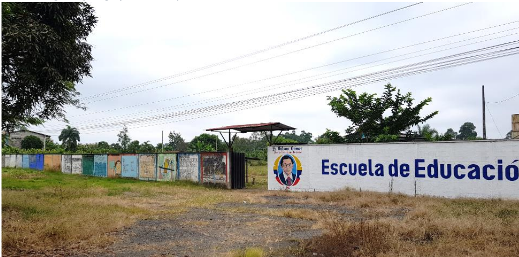
Ilustración 61-Unidad educativa del recinto Toquilla Fuente: Registro fotográfico de campo – 2020
