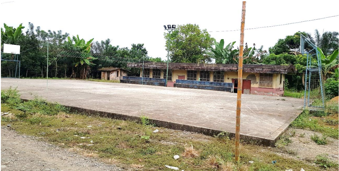
Ilustración 58-Unidad educativa del recinto Bella Unión Fuente: Registro fotográfico de campo – 2020
