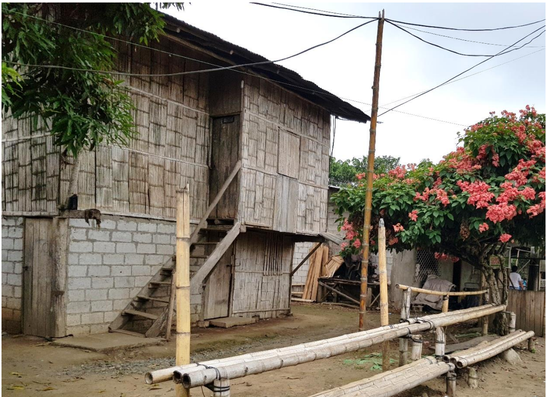
Ilustración 76-Vivienda tipo del recinto La Sucre Fuente: Registro fotográfico de campo – 2020
