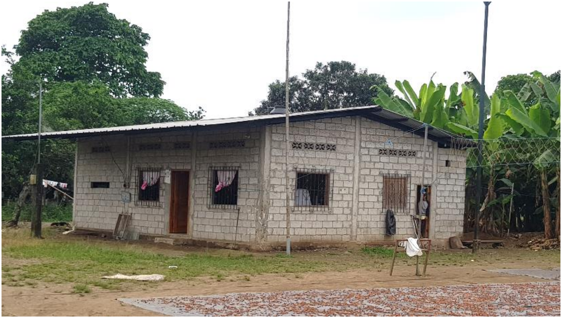
Ilustración 75-Vivienda tipo del recinto El Retiro Fuente: Registro fotográfico de campo – 2020
